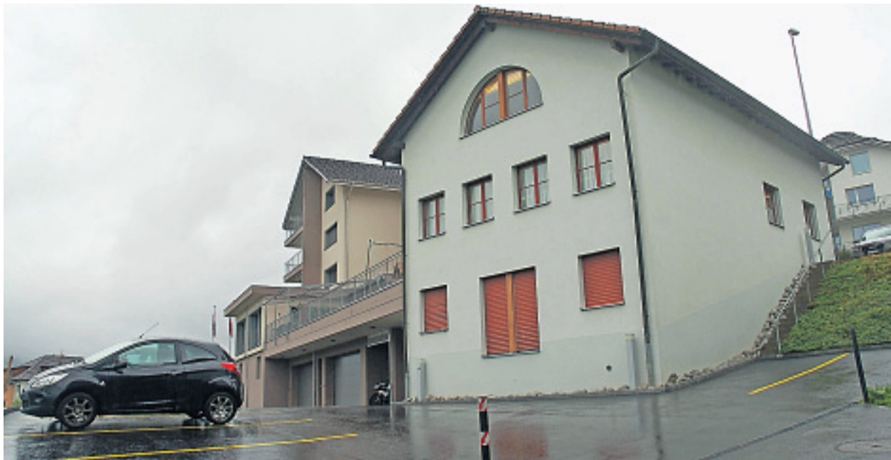
Das Gemeindehaus (rechts) erhält eine neue, wärmedichte und farblich abgestimmte Fassade. Die Heizenergie wird vom benachbarten «Hirschen» (links) bezogen.
